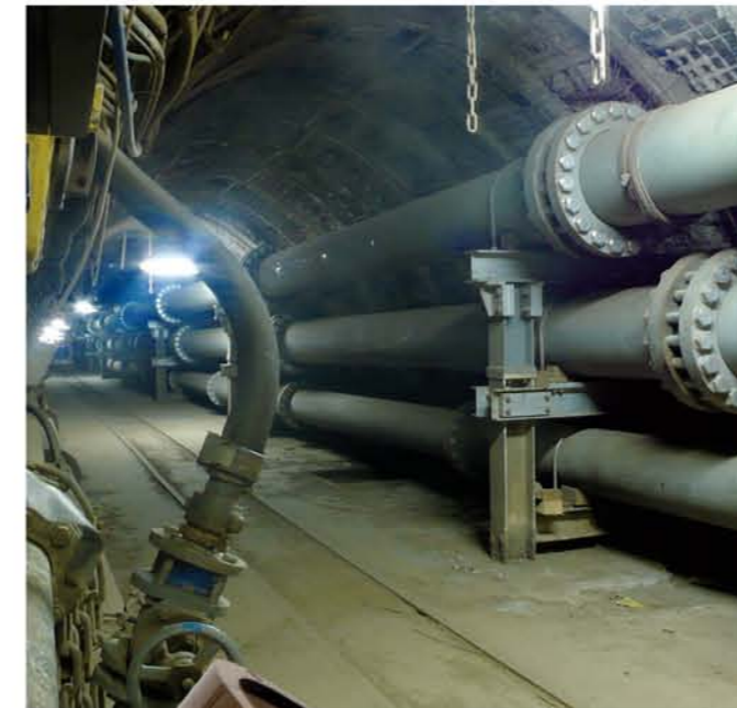
Rohrleitungen im Weltkulturerbe Zeche Zollverein in 1000 Meter Tiefe.
